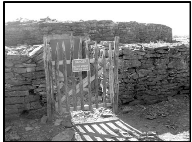
Une barrière et une plaque interdisent aujourd'hui tout accès au couloir et à la chambre (03/06/2010).
